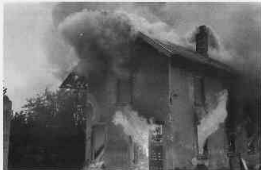
Heißer Abbruch eines Gebäudes vom ehemaligen Britschen-Hof (Alte Poststation). Diese Maßnahme wurde auf Empfehlung des Landratsamtes Lörrach von den Abteilungen Efringen-Kirchen und Wintersweiler durchgeführt und überwacht.
