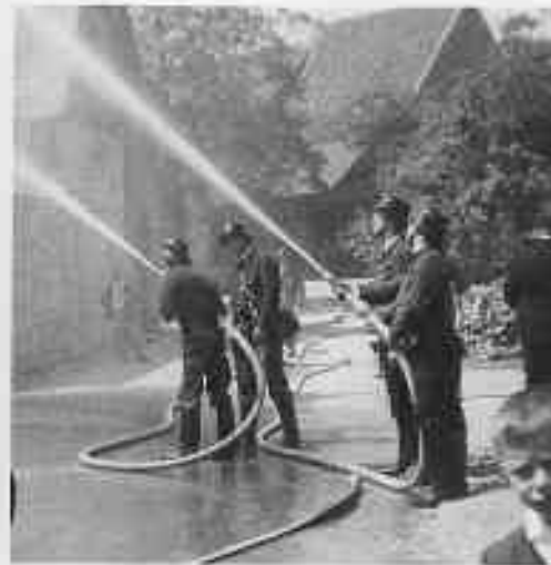
Alle Rohre "Wasser marsch"
